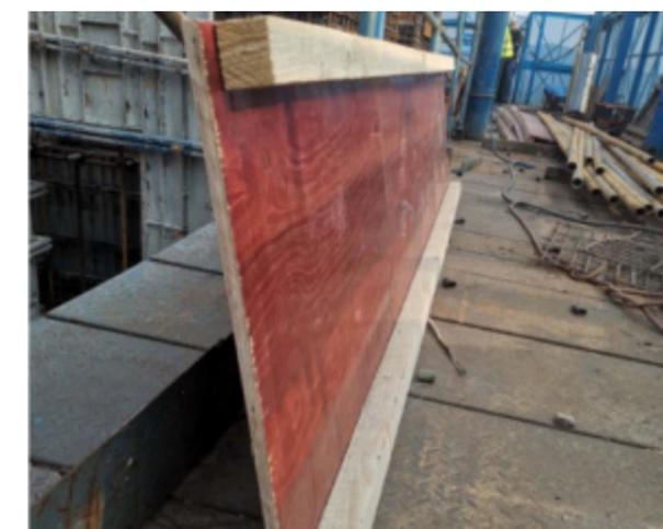
图4 加工固定木模板木枋整体构件
