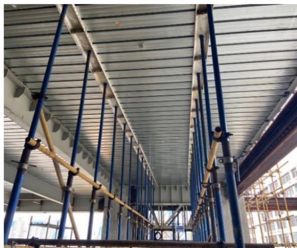
图10 支撑体系搭设完成
