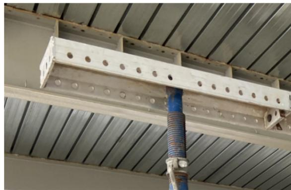
图8 顶托子母管连接
