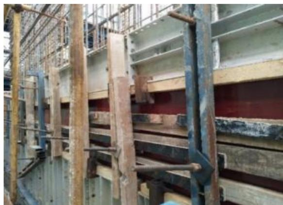
图7 安装连接顶板C槽/K板及加固
