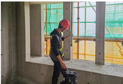
凸窗水平度检测
