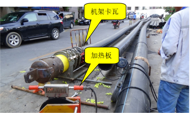
图5.7 管道焊接
