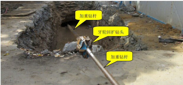
图5.5-2 牙轮回扩钻头扩孔图
