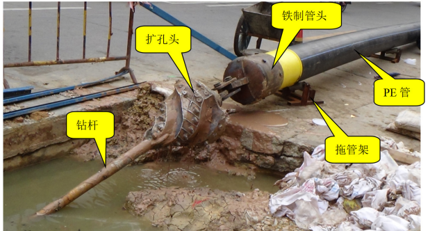
图5.8-1 管道回拖钻具组合
