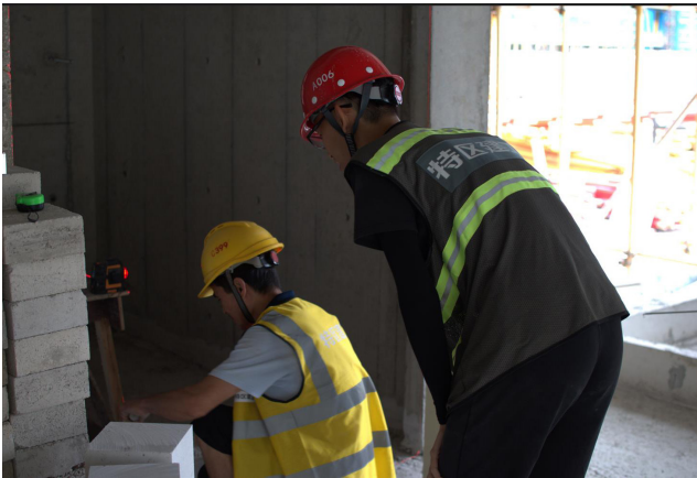
大学生独自指导工人施工
