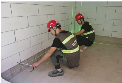
墙体方正检测
