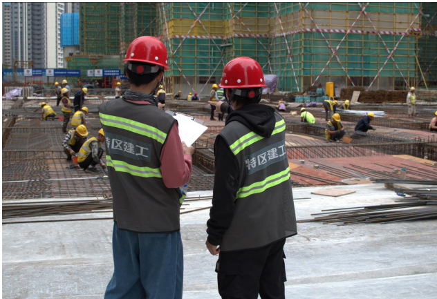
大学生们现场讨论施工，检查施工质量
