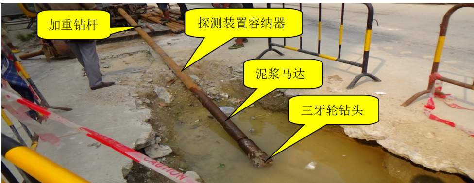
图5.4-8 岩石导向钻头入土
