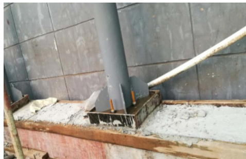
图8 钢管立柱现场安装图
